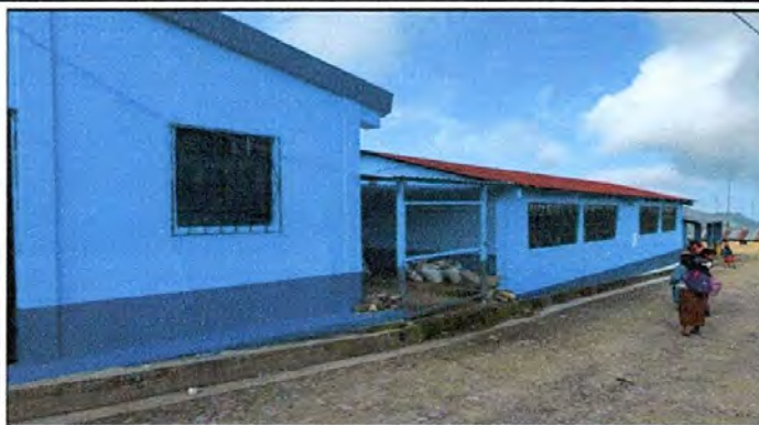
Foto 2: Pintura externa de los muros del establecimiento.
