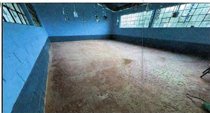
Foto 5: Picado en el concreto del suelo de la aulas para su posterior instalación de piso de granito.
