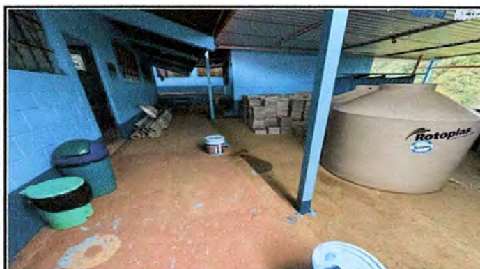
Foto 4: Vista de materiales y Tinacos a instalarse.
