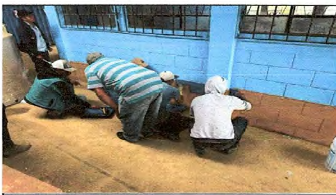
Foto10: Trabajos de pintura por parte de padres de familia. Muros exteriores.
