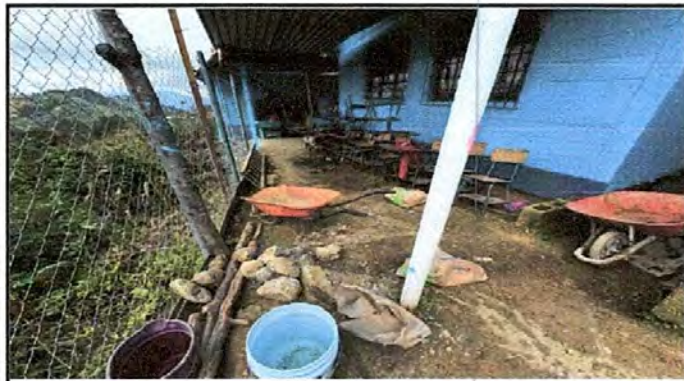
Foto7: Inicio de trabajos para losa trasera del establecimiento.
