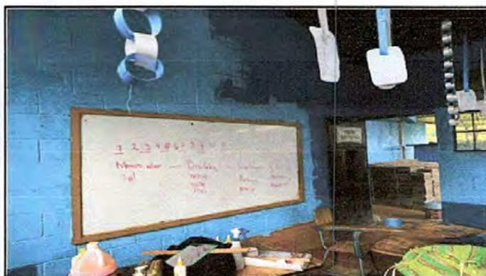
Foto9: Trabajos de pintura interior en la aulas.
