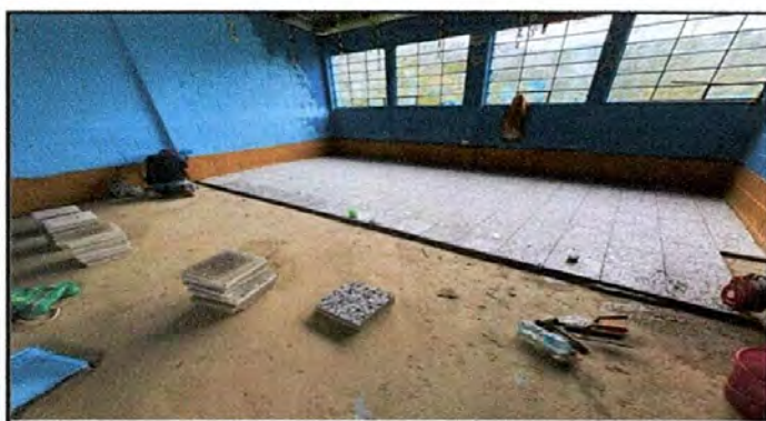
Foto 6: Vista de un aula con la mitad de piso de granito puesto.
